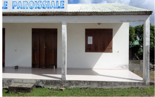
Photo n° 8 : Salle paroissiale du Bourg
